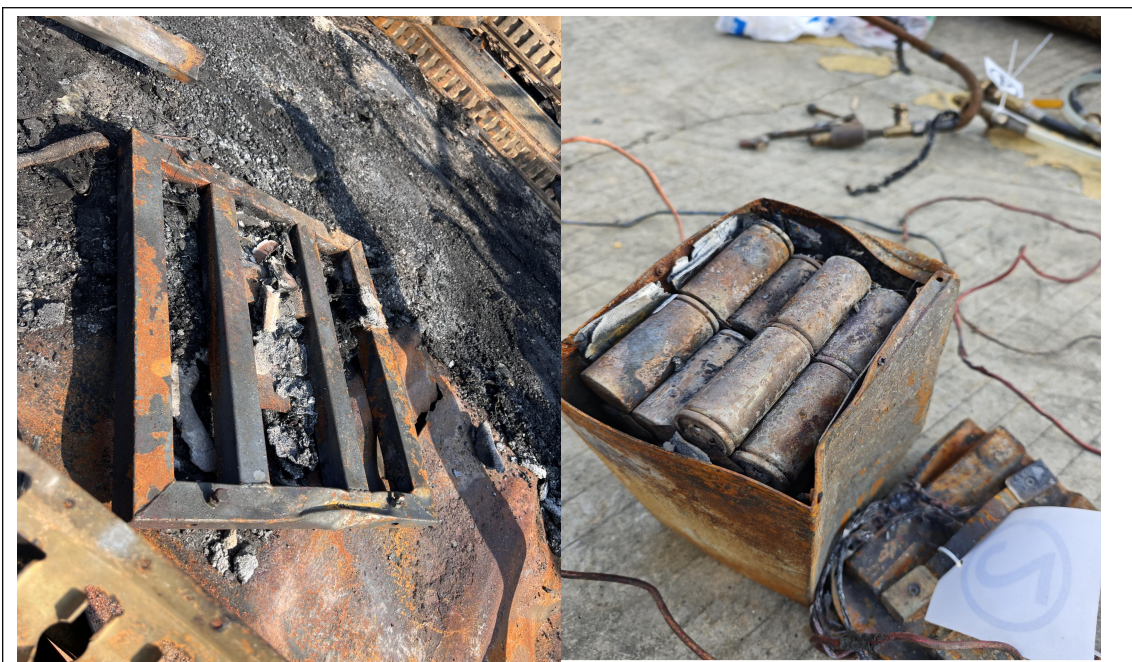
图 10、11 倒气泵固定底座及事发蓄电池
