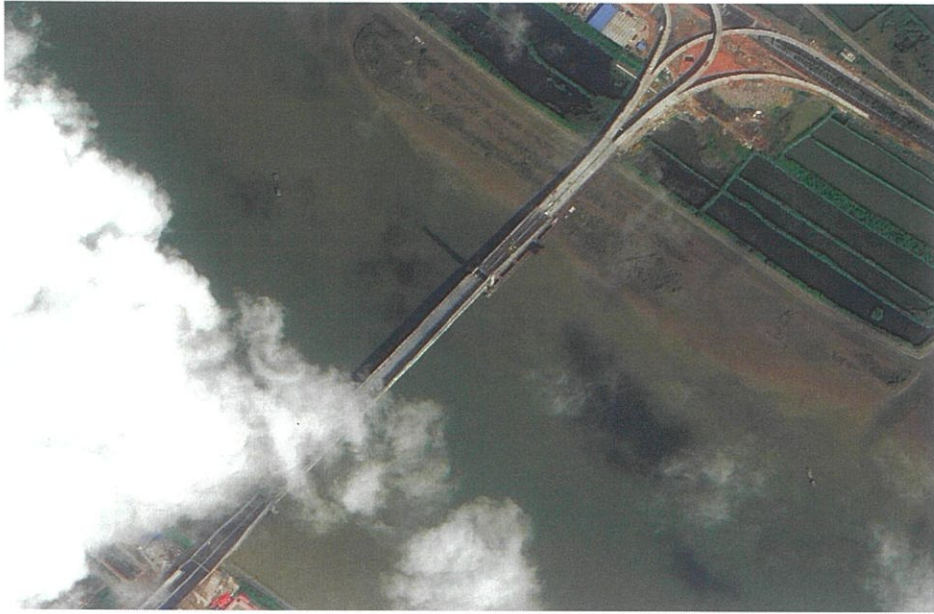
图7 事发当天上午10时35分施工作业现场卫星云图
