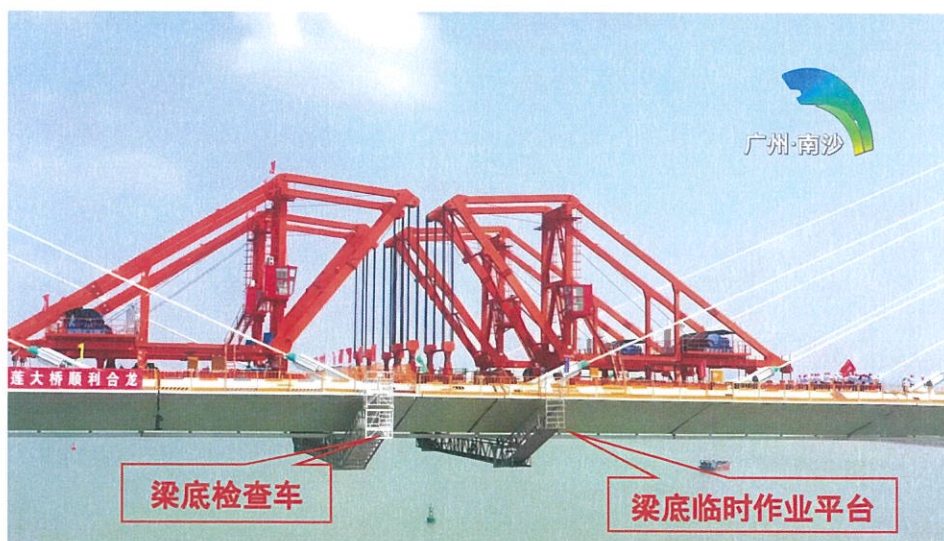
图 3 红莲大桥合龙照片
