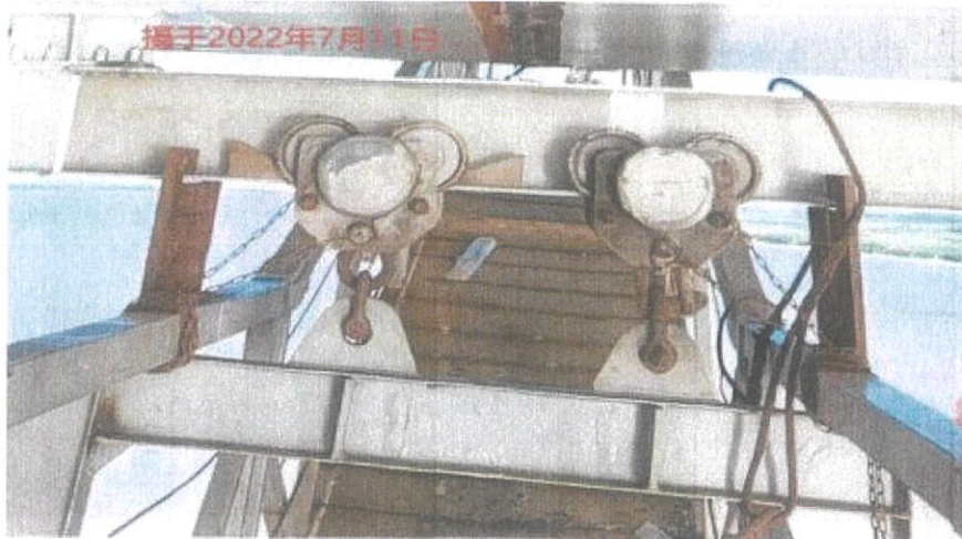
图6 临时作业平台使用过程中实景图
