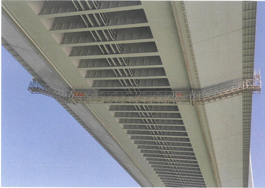
图2 梁底检查车现状图
