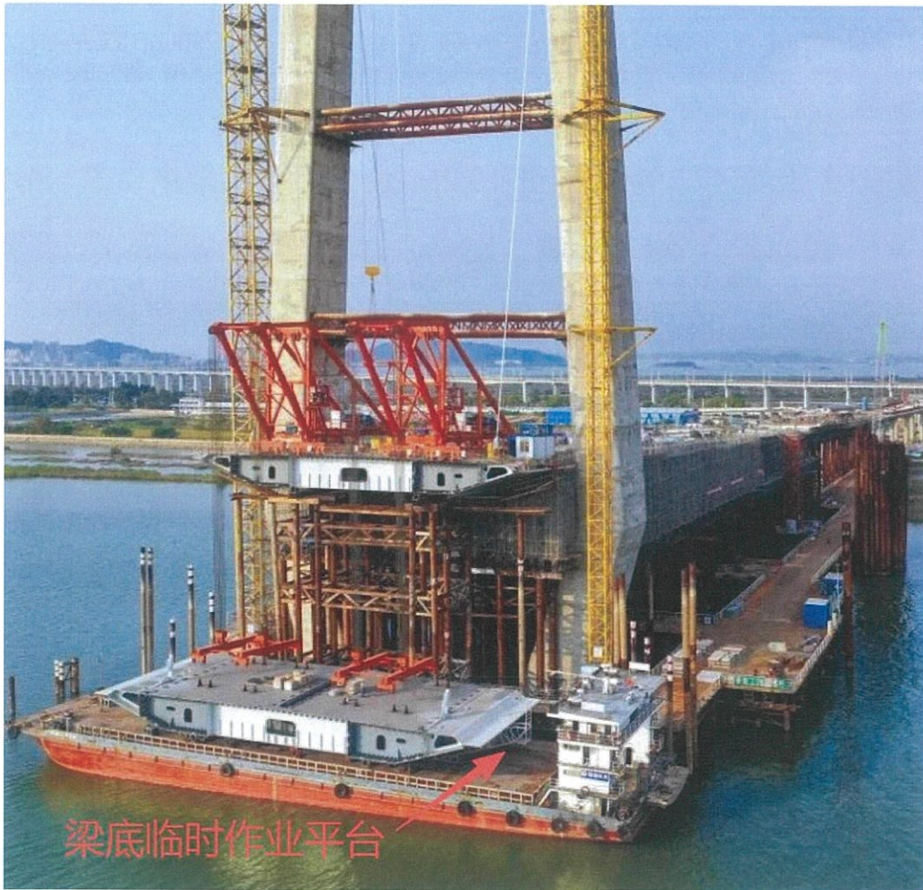
图 4 梁底临时作业平台安装时的照片
